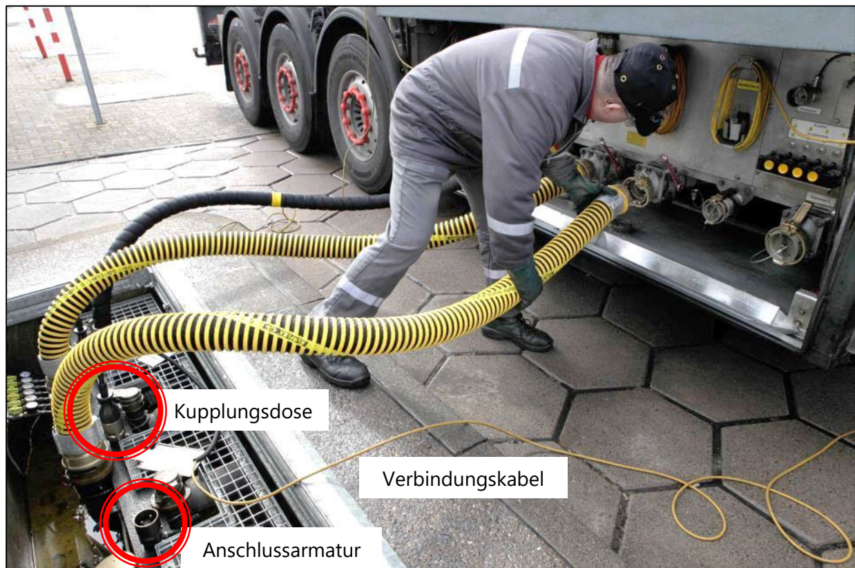
Abbildung 1: Tankbefüllung vom Tankwagen
