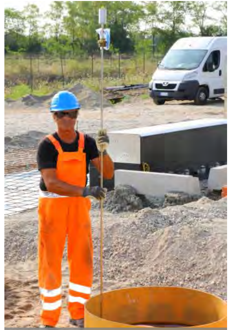
... to the manhole.
